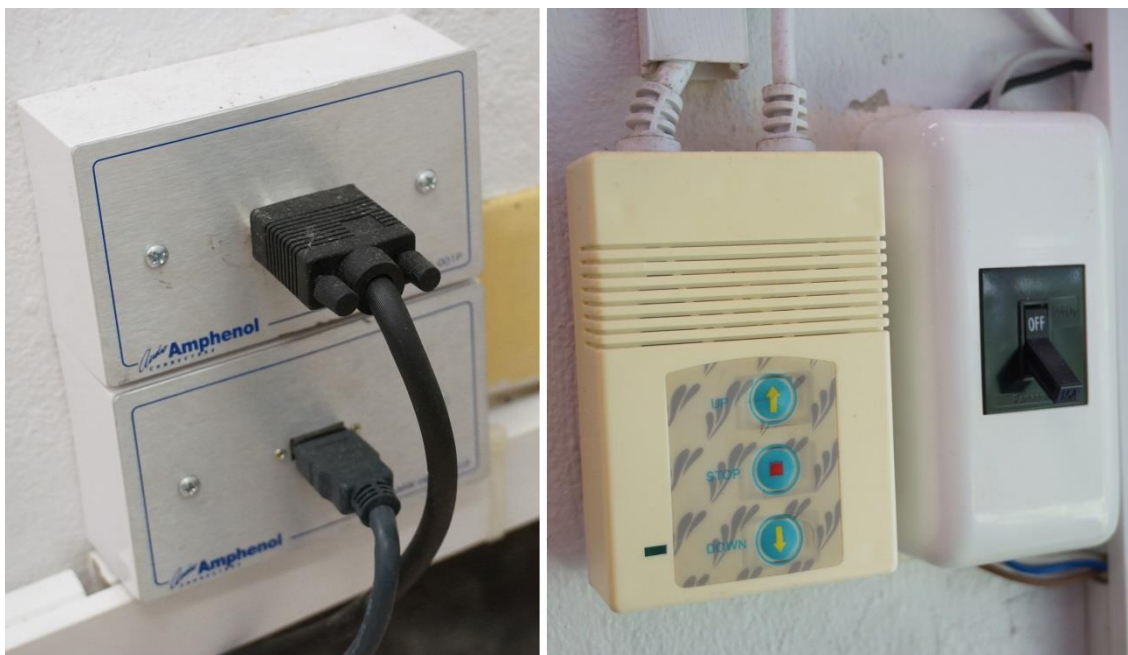
ภาพที่ 4.13 เ้ารับสัญญาณภาพ สวิตช์เปิด-ปิด และสวิตช์ควบคุมการทำงาน
