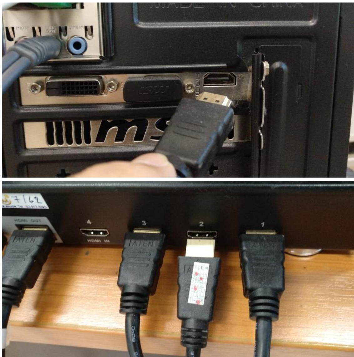
ภาพที่ 4.22 การต่อสายสัญญาณจากเครื่องคอมพิวเตอร์ไปยังเครื่องเลือกสัญญาณภาพ
